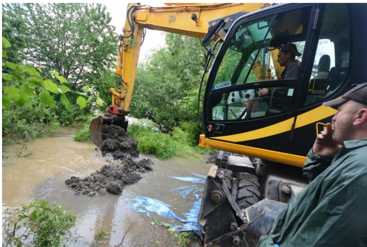
Zahrazení propustí pod dálnicí za pomoci těžké techniky
