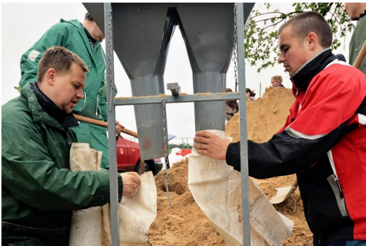
Plnění pytlů pískem
