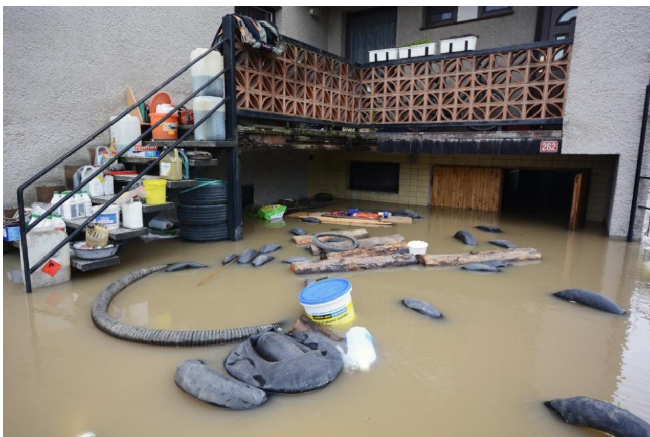
Zatopené garáže v bytovkách
