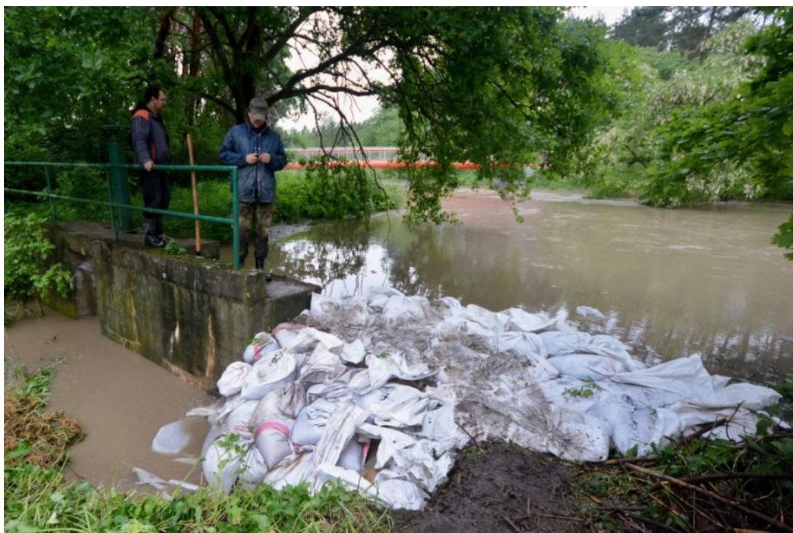
Protržená ochranná hráz na odtokovém potoce rybníka Peklo ucpaná pytlí s pískem
