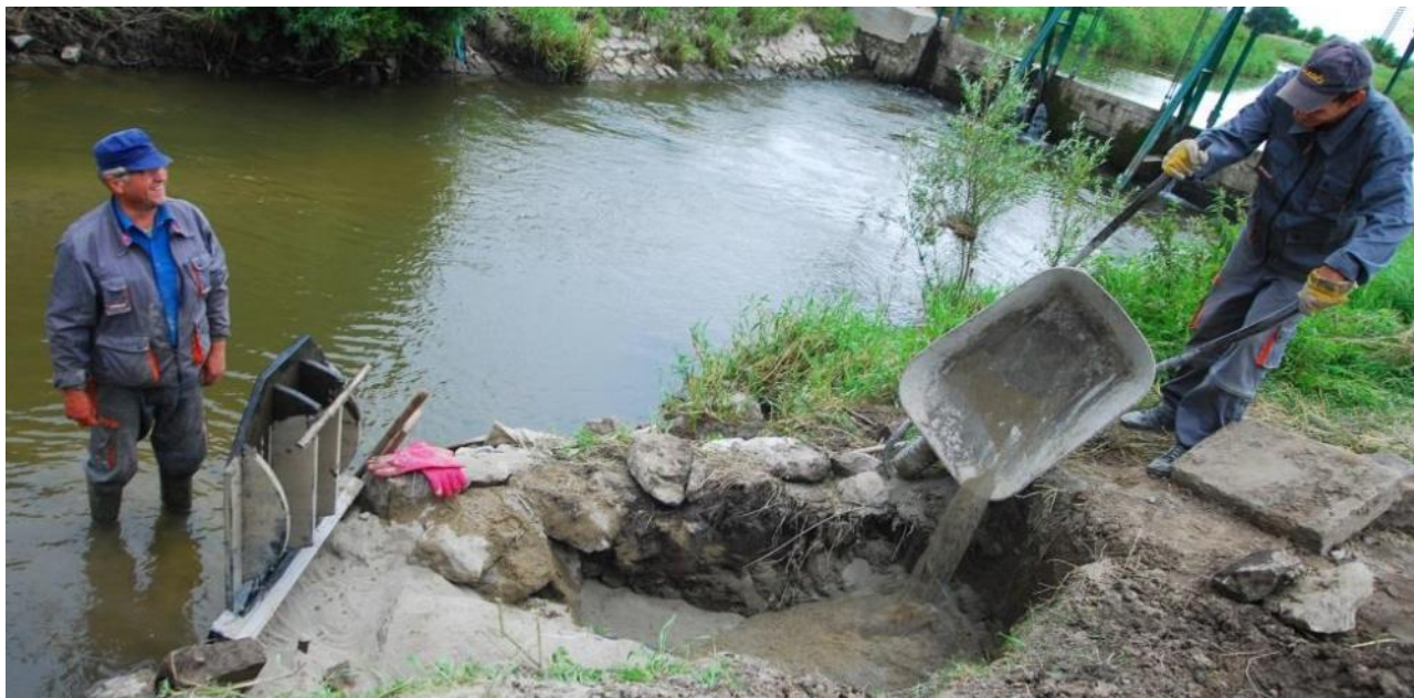
Oprava posunutých trubek vyústění melioračního příkopu – betonáž (červenec 2013)
