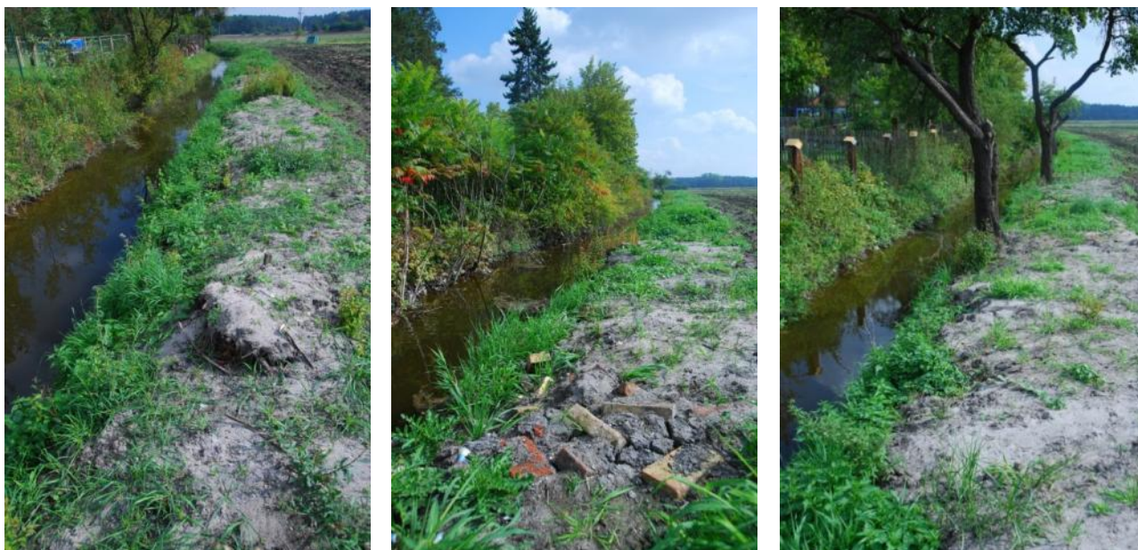
Odtokový příkop rybníka Peklo vyčištěný a odbahněný v září 2011
