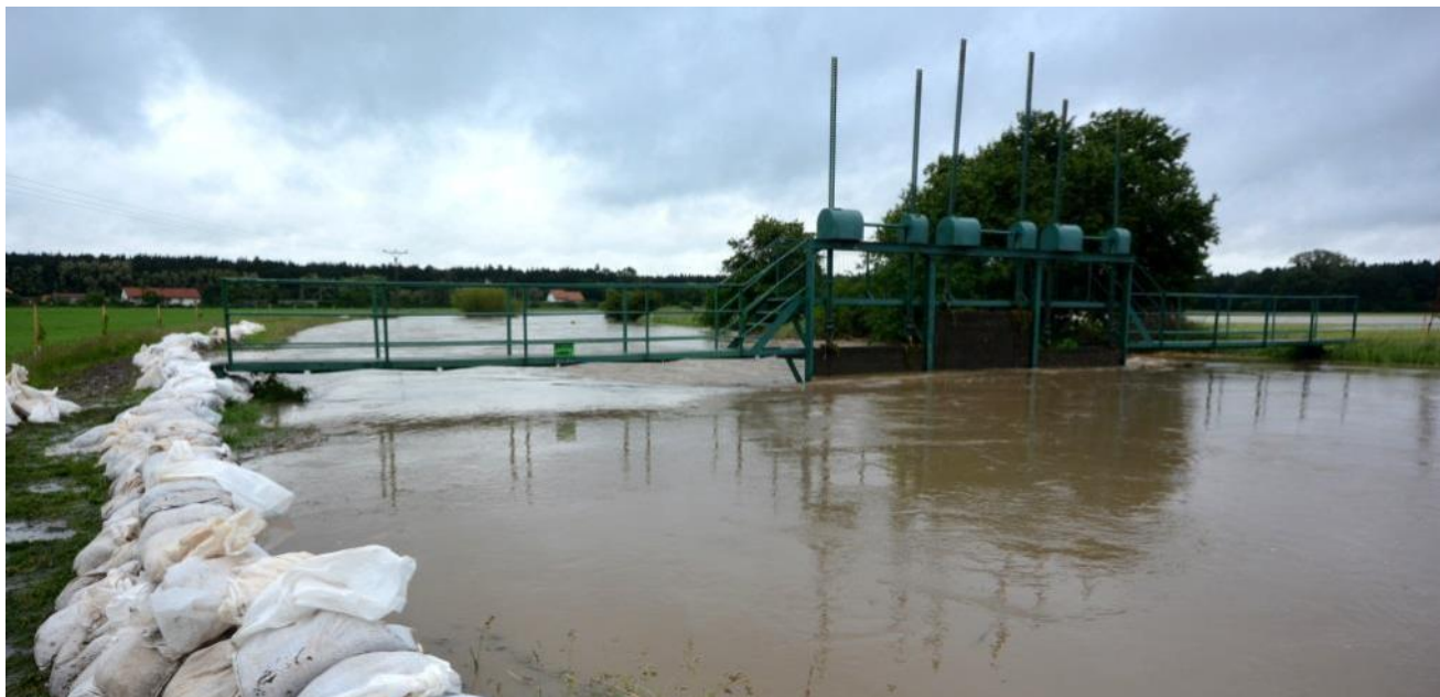
Pytle na hrázi u stavidla
